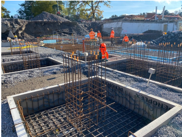
GJUTNING AV GRUND
