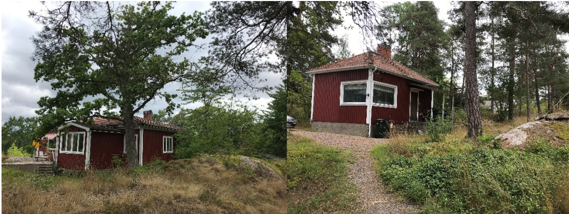
Tv: Huvudbyggnaden på Björknäs 10:124 med bevarandevärd ek intill. Tb: Den mindre byggnaden omgiven av äldre tallar
