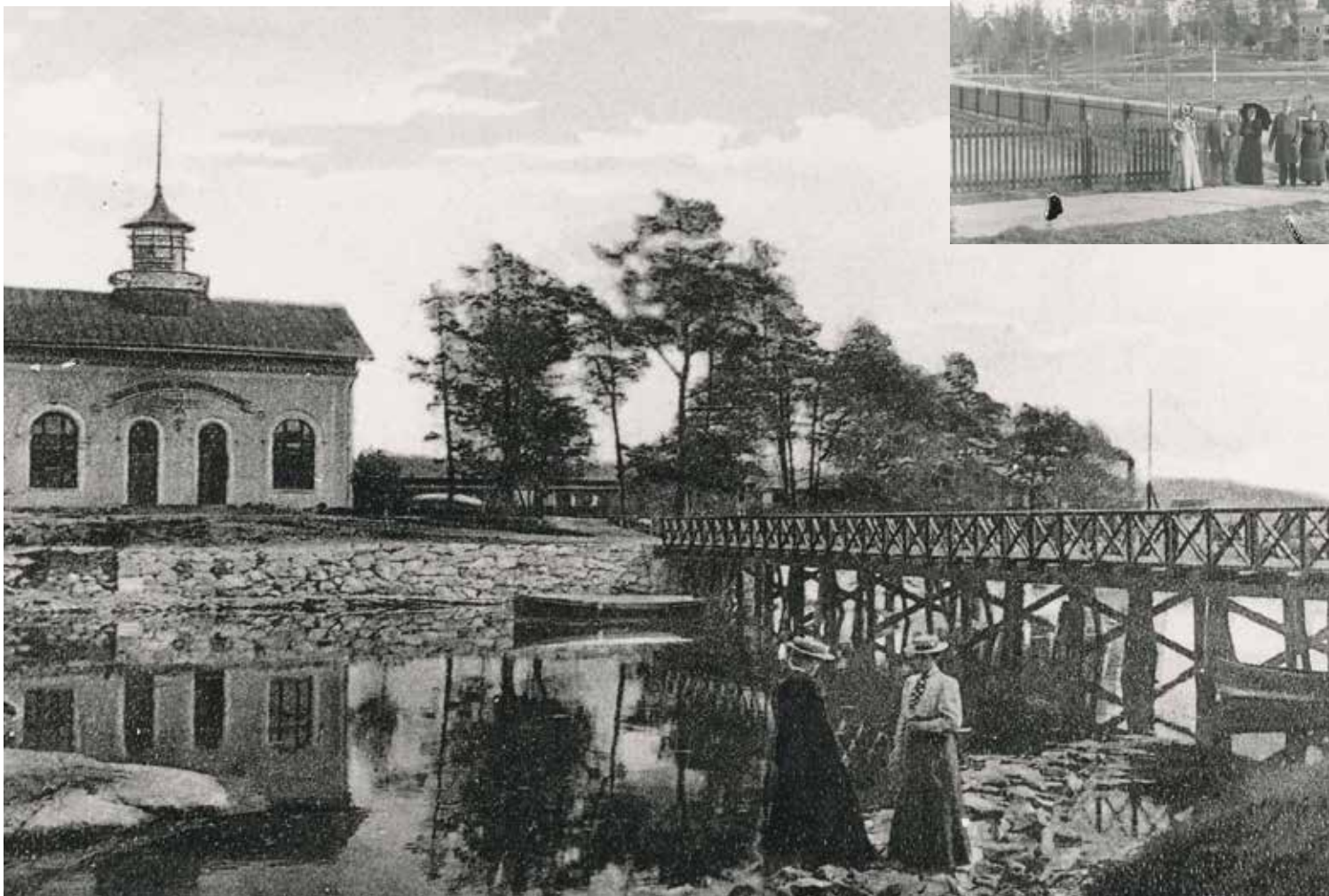
Saltsjöbadens elverk vid Dalaröbryggan är det äldsta elverkshuset i Sverige.
