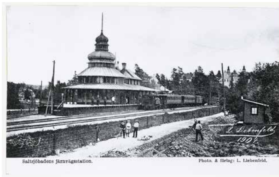
Saltsjöbadens station stod klar i juli 1893. Stationen stängdes 1947, men fick stå kvar fram till 1954 då den revs.
