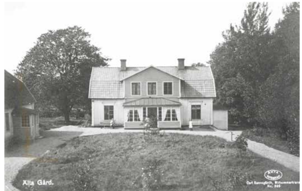
Mangårdsbyggnaden på Älta gård. Vykort ca 1910.
