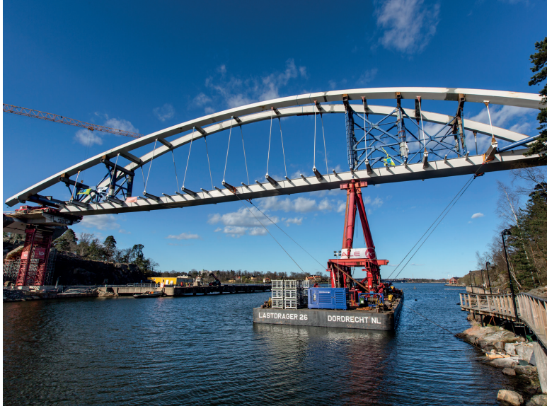
Två stora pontoner hade viktiga uppgifter när Svindersviksbron sköts ut över viken.
