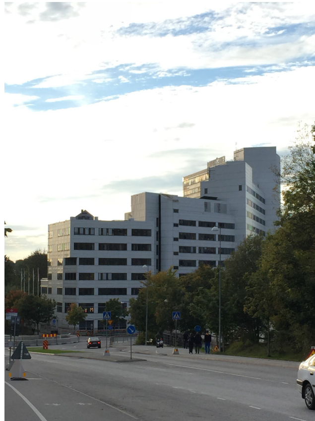
DanvikCenter: Komplexet byggdes 1986 för Viking Lines behov. Idag huserar ett 40-tal företag här. Arkitekt: CAN Arkitektkontor. Den högsta delen är 14 våningar. Foto: Henrik Svensson
