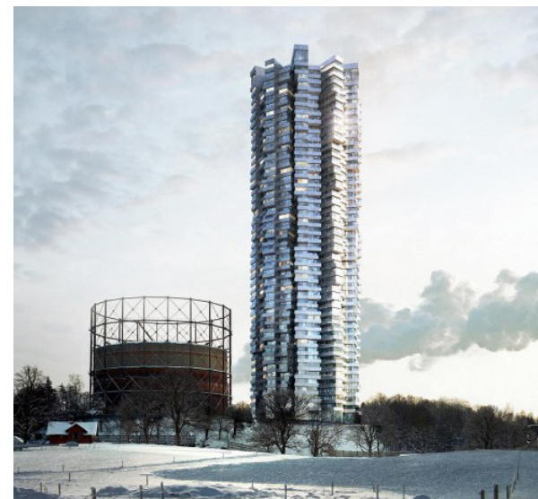
Hjorthagen, 140 meter/45 våningar. Arkitekt och bild: Herzog & de Meuron.
