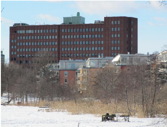
Fläktfabrikens före detta huvudkontor: Den 12 våningar höga tegelbyggnaden färdigställdes 1959 som huvudkontor för Svenska Fläktfabriken. Arkitekt: Ture Wennerholm. Huset byggdes om till flerbostadshus 2004. Foto: Johan Aspfors.
