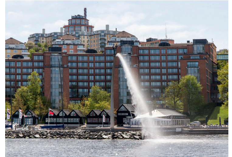
Nacka Strand: 1899 uppfördes det en motorfabrik där det tillverkades en tvåtaktsmotor med tändkula. Området utvecklas idag från ett utpräglat företagsområde, framförallt kontor, till ett område med större inslag av bostäder. Bebyggelse i upp till 16 våningar. Foto: Jan Johansson
