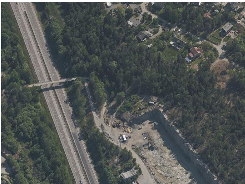
Foto från väster över fastigheten sommaren 2018. Vändplanen är idag färdigbyggd och fastigheten består till största del av skog bortsett från den gamla dragningen av cykelvägen.
