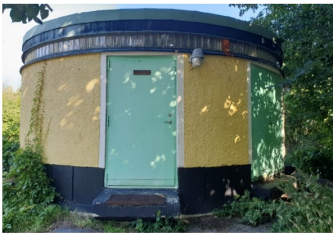
Bilden visar avloppspumpstationen SPU804 Sävstigen före renovering.
