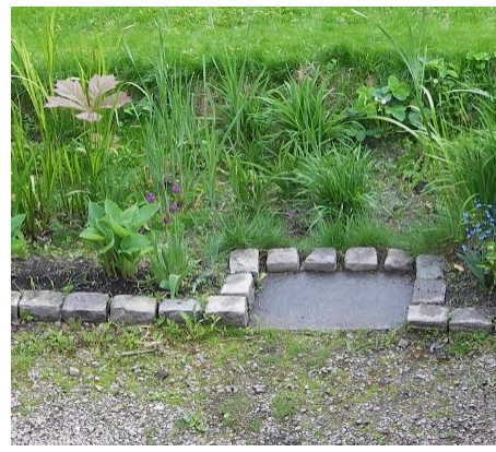
Inlopp till regnbädd med försedimentering, som möjliggör enklare skötsel. Oslo, foto av Bent Braskerud, Oslo kommun.
