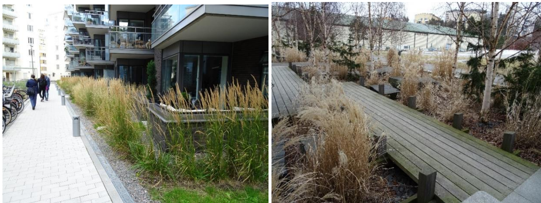
Figur 10. Ett annat alternativ är att dagvatten avledas till regnbädden över en nollad kantsten eller hål eller uttag i kantstenen. Räckan eller planteringskydd behövs ofta avgränsa en öppen regnbädd av säkerhetsskäl.
