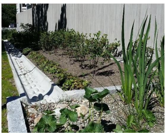
Figur 6. Bilderna visar exempel på seriekopplade regnbäddar på kvartersmark samt exempel på överfall och dämmen. Rännor kan avleda dagvattnet till regnbäddar men även fungera som bräddning i ett seriekopplat system.
