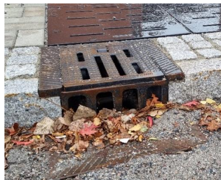
Figur 9. Täckta regnbäddar med träd och olika konstruktioner, markgaller och inloppslösningar.
