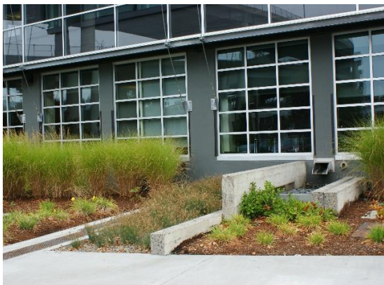
Figur 5. Illustrationer över nedsänkt regnbädd som kan ta emot dagvatten från tak och markytor. Inflödet sker via stuprör och släpp i kanten. Överskottsvatten avleds via dränering och bräddbrunn.
