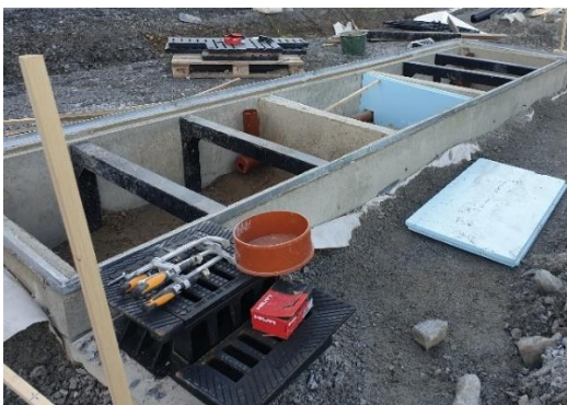
Figur 9. Täckta regnbäddar med träd och olika konstruktioner, markgaller och inloppslösningar.
