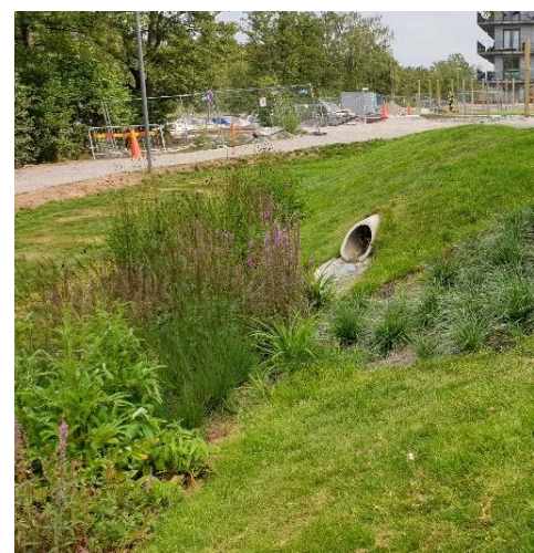
Figur 12. Öppna regnbäddar med endast markvegetation i form av buskar och perenner.
