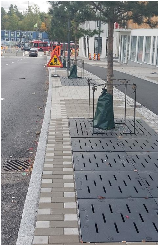
Figur 8. Övre bilden genomsnitt av täckt regnbädd. Nedre bilden anlagd täckt regnbädd med träd i Vikdalsvägen Nacka. Inloppsbrunn från gatan och GC-väg synns på bilden.
