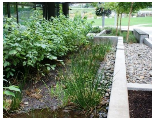
Figur 5. Illustrationer över nedsänkt regnbädd som kan ta emot dagvatten från tak och markytor. Inflödet sker via stuprör och släpp i kanten. Överskottsvatten avleds via dränering och bräddbrunn.
