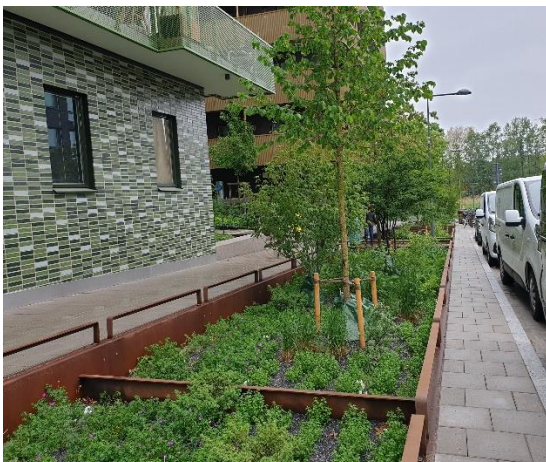
Figur 11. Öppna regnbäddar med träd och markvegetation.
