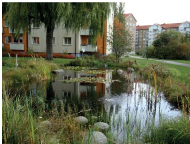
Dagvattenhantering med dagvattendamm, Sweco, dagvattengruppen
