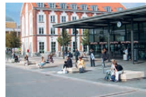
Bytespunkten integrerad med stadsmiljön, att vänta på tåget bidrar till stadslivet. Vejle, Danmark.
