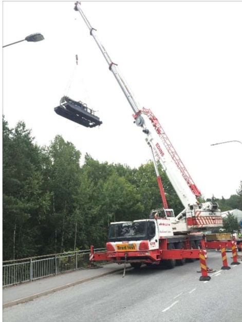
Figur 11 Sugponten lyfts över trädtopparna. Foto Järven Ecotech
