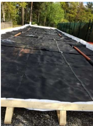
Figur 9 Avvattningsram med geotextilsäckar
