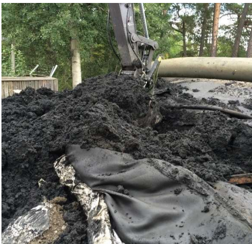
Figur 18 Geotextilsäck skärs upp och grävs ur
