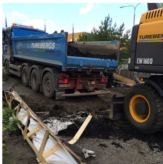
Figur 17 Borttransport av avvattnat sediment
