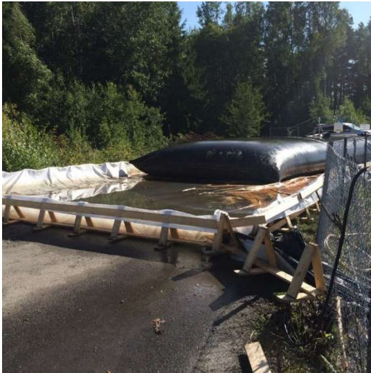
Figur 14 Sedimentavvattning i geotextilsäck
