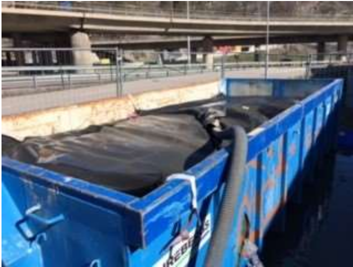
Figur 16 Avvattning i container. Avsättningsmagasin Svindersvik
