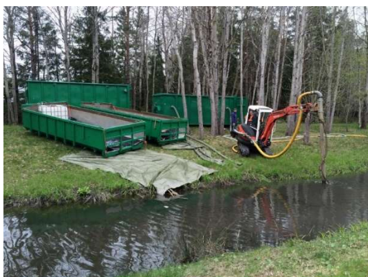
Figur 13 Rensning med sugmustycke Myrsjöns dagvattendamm
