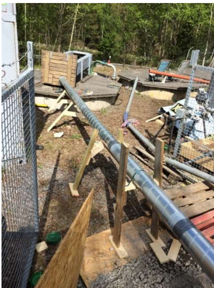
Figur 15 Speciallösning med rörsystem från geotextilsäck till damm.
