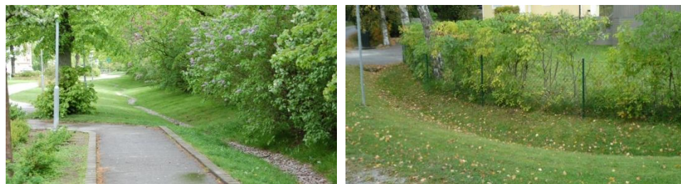
Figur 5. Exempel på svackdiken med och utan dränerande botten.
