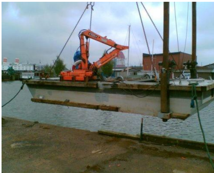
Figur 13, Arbetsplattform med stödben.
