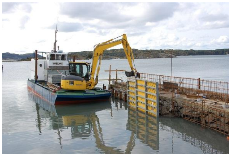
Figur 11, Mindre enskopeverk utför pirarbete.
