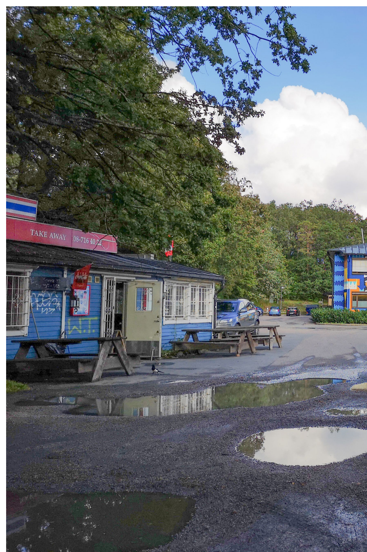
Matkiosk, fastigheten Sicklaön 361:1
