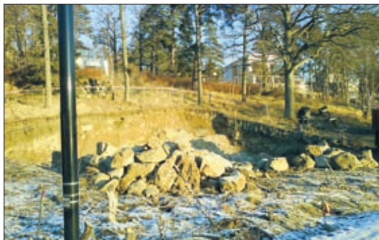
En vanlig syn på en byggarbetsplats när markarbeten för slutningshus pågår.
