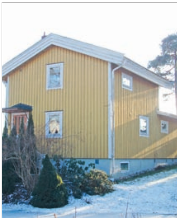
Ett hus på en tomt som för ögat uppfattas som relativt plan har helt anpassat sig till tomten med en sockel som tar upp höjdskillnaden.
