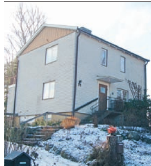
Tomter med stora höjdskillnader är vanliga i Nacka. Tänk på att planera tomten och huset så att entrén är tillgänglig även för rörelsehindrade.
